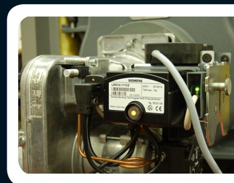
Sowohl Heizöl EL Standard wie auch Heizöl schwefelarm nach DIN 51 603 können problemlos mit dem Blaubrenner des Öl-Brennwert-Kessels verfeuert werden.
